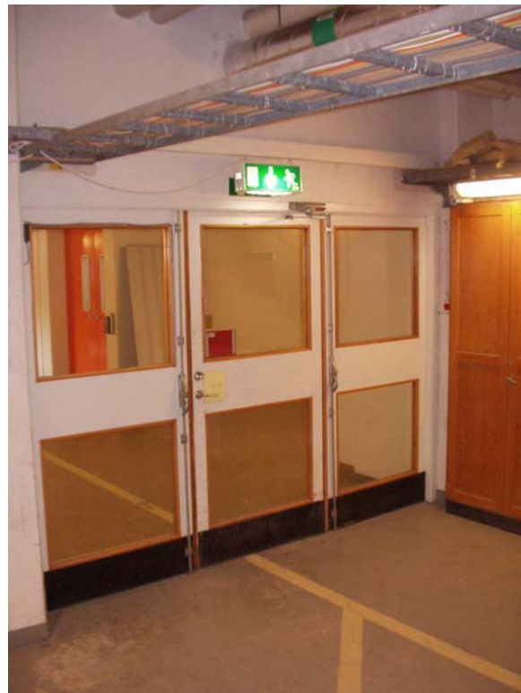
Figur 4. Bild av utgång D utan avmaskering av glaspartiet.
