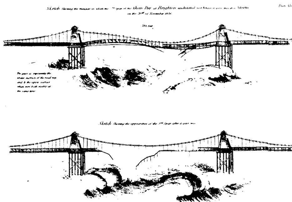
Figur 33 Överstelöjtnant REIDS skisser över Brighton Chain Piers kollaps den 30 november 1836
