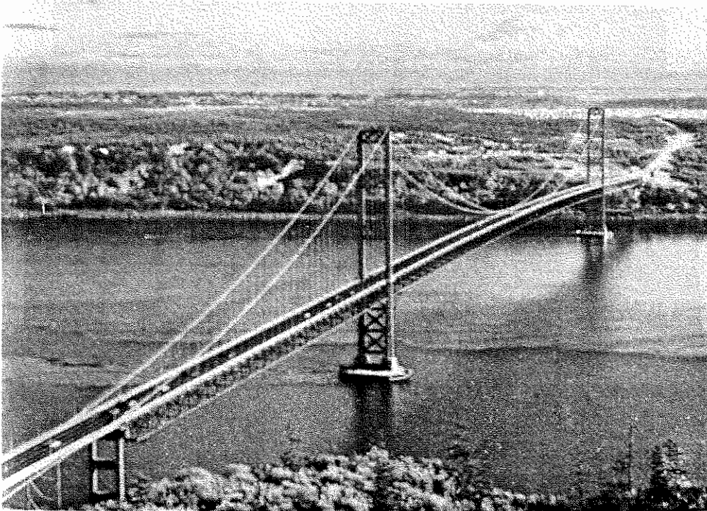
Figur 34 Nuvarande Tacoma Narrows Bridge, öppnad för trafik i oktober 1950
