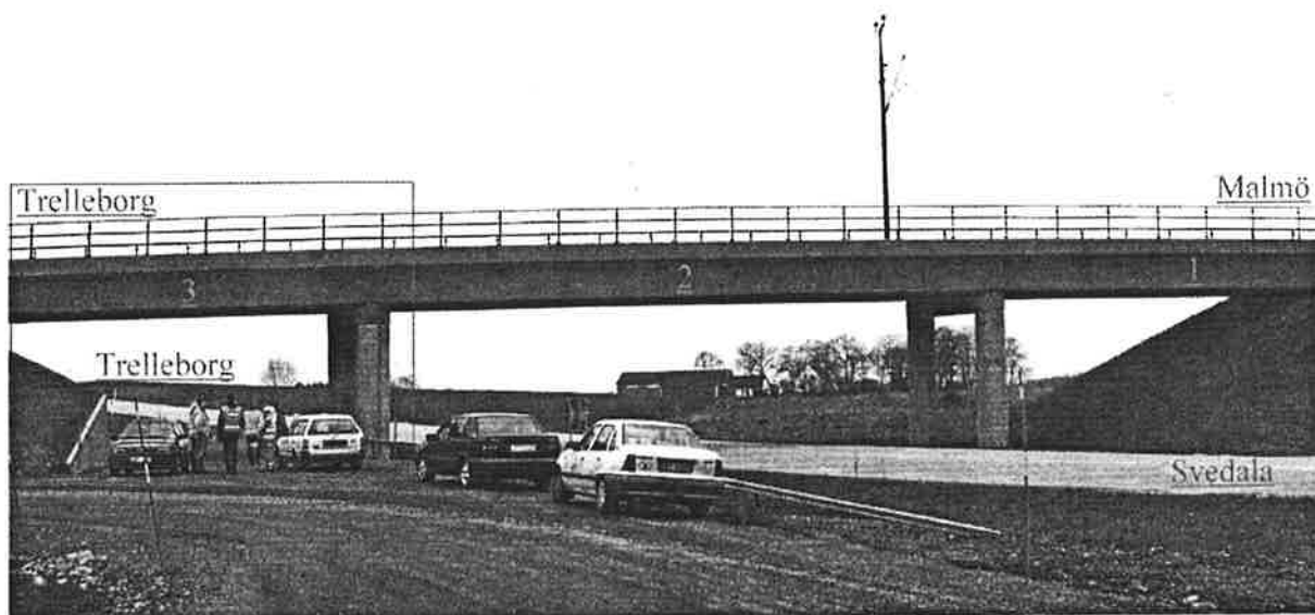
Figur A2 Järnvägsbro över väg 108 vid Vemmerlöv.
