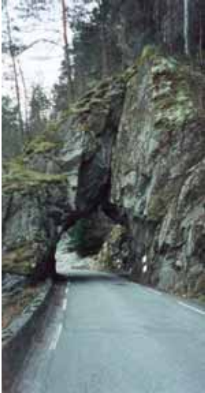
Figur 5: Vegen mellom Dalseid og Eidsland i Hordaland med en av sine mange håndborete tunneler fra 1930-tallet. Denne er nesten som en skulptur. Foto: Liv Marit Rui
