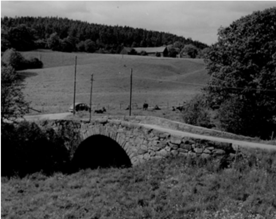
Bild 4. "Finabo bro" över Häggån, öster om Finabo, Fritsla socken, Marks kommun, Västergötland. Bron byggdes i mitten av 1800-talet och ligger väl synlig i ett pastoralt landskap. Bron har klassats i den högsta bevarandegruppen såväl i RAÄ:s broinventering från mitten av 1950-talet som i Älvsborgs läns broinventering från 1979-80. Bron låg tidigare på det allmänna vägnätet men tillhör sedan mitten av 1990-talet det enskilda vägnätet. Foto från "Kolmska broinventeringen", mitten av 1950-talet, Vägverkets museum.
