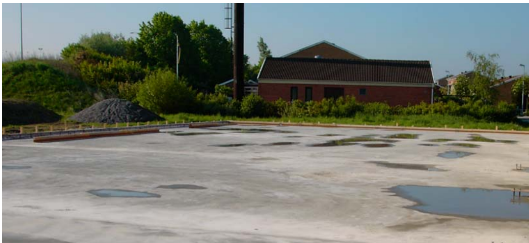
Figur 13.1 Exempel på nödvändig observation för att beräkningar av vatteninsugning skall bli tillförlitliga. Foto: L-O Nilsson
