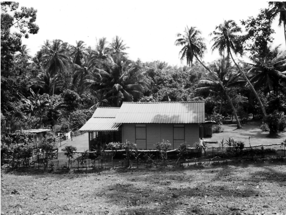
Kampung house at Pulau Ubin.
