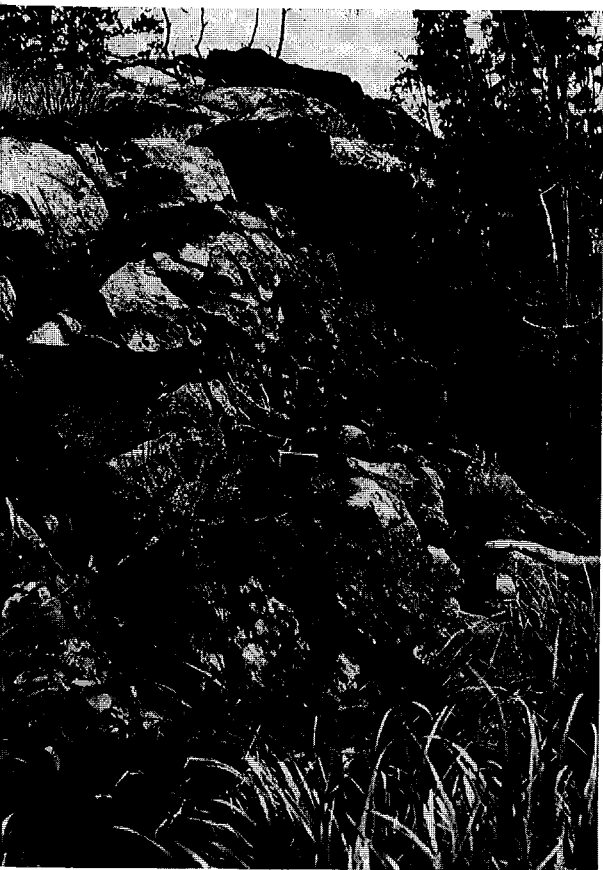
Detalj av stenbrottet. Berget är starkt uppsprucket, främst på grund av frostsprängning
