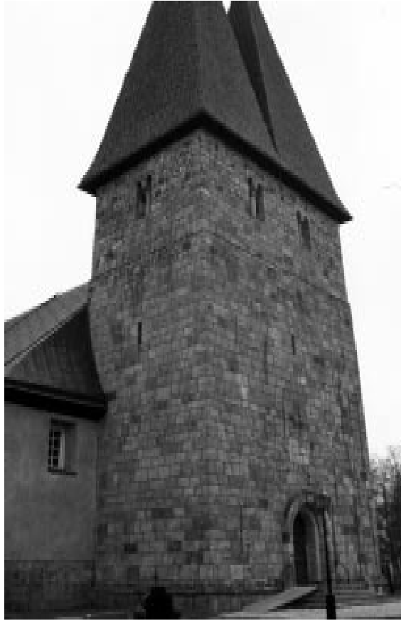
Fig. 49 Det romanska tornet uppfört av granitkvadrar är det enda som återstår av den medeltida kyrkan i Rydaholm. Kyrkan revs på 1790-talet. Foto förf.
