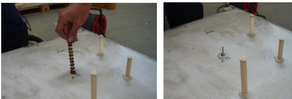
Figur 42. Montering av OE-stav, med två Temp-trissor och åtta RF-trissor, i mätthål. Monterad OE-stav samt foderrör med extra tätning mot betongytan.
