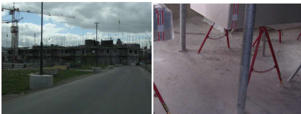
Figur 52. Bostadshus under uppförande i Malmö samt mätpunkt med tre monterade OE-stavar
