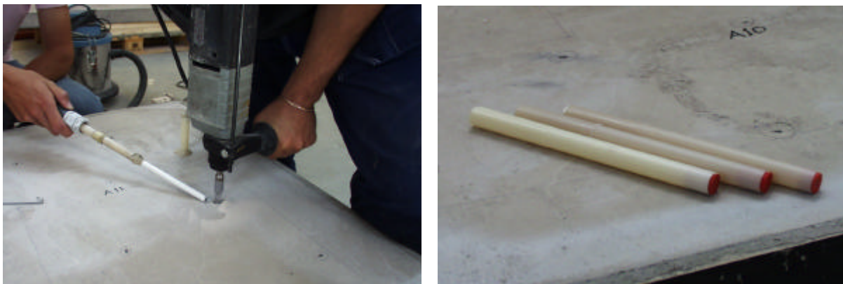
Figur 41. Borrning av mätthål och dammsugare med smalt munstycke. Foderrör med tätad botten för pluggning av mätthålen.
