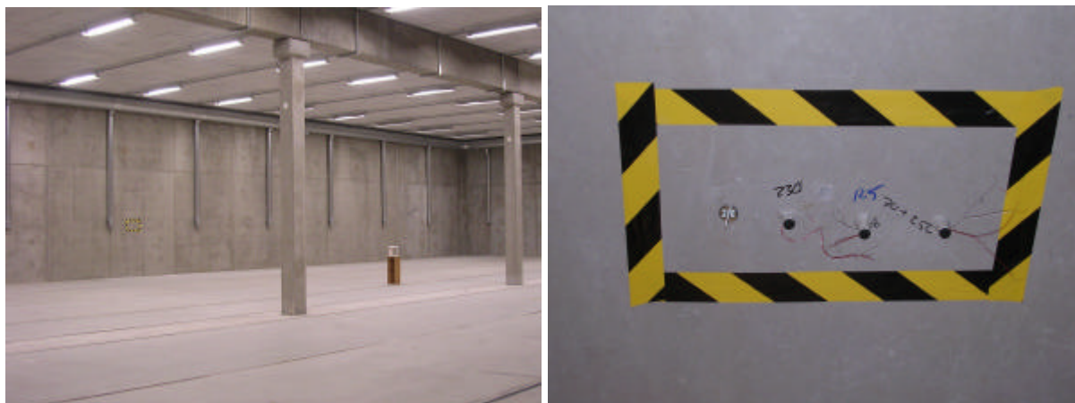
Figur 55. Lokal med betonggolv, -väggar och stomme. Mätpunkt med OE-stav samt tre kvarsittande av typen Humi-Guard.
