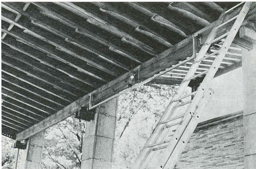
Fig. 10. Märbrygga för mätning av nedböjning på träbjälkar.
