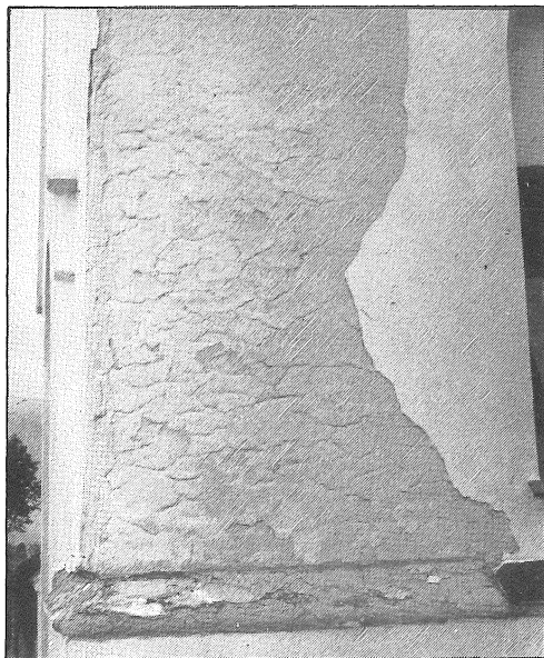
FIG. 5:18. Skadeutseende efter andra renoveringen, närbild.
