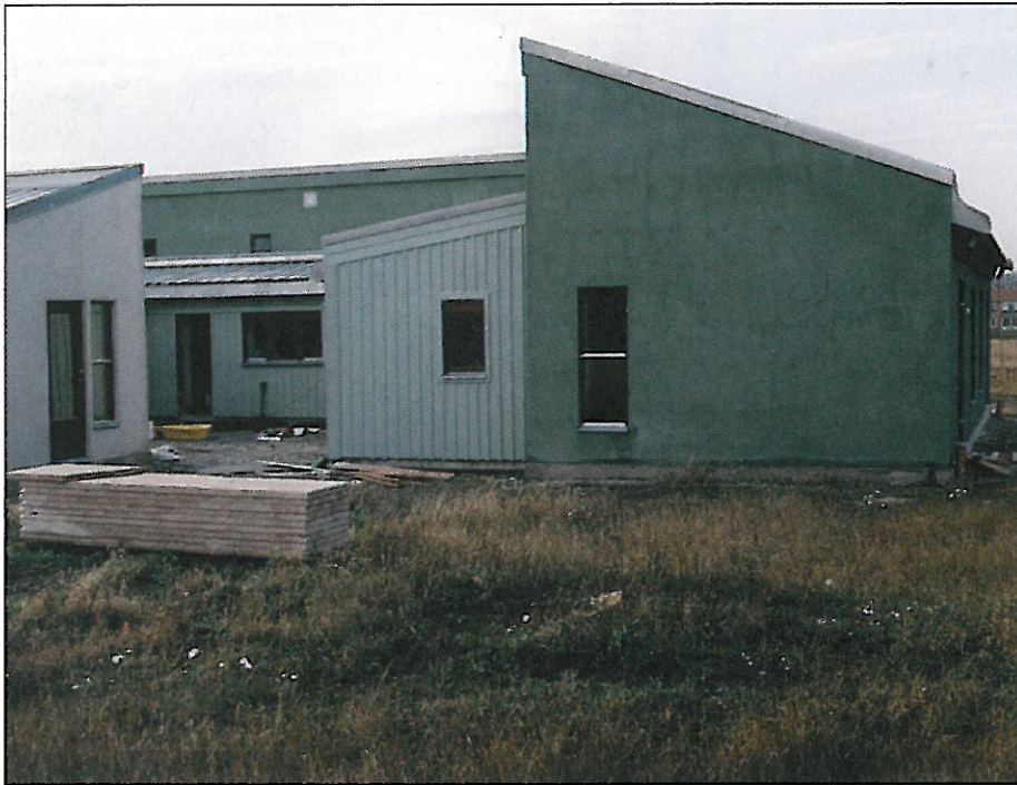
Figur 6. Det färdiga experimenthuset i Staffanstorp utanför Lund.
