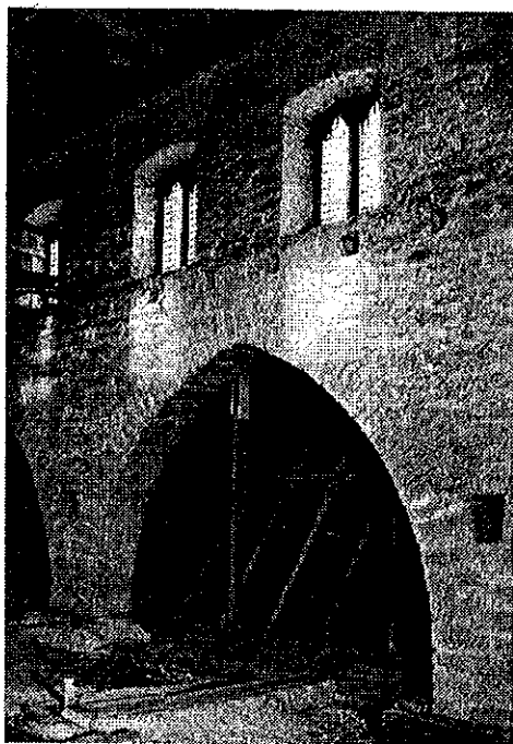
Fig. 10. Klerestorieetagen eller magasinsloftet ved Mariakirken i Visby. Foto 1975 i SvK 175, 1978.
