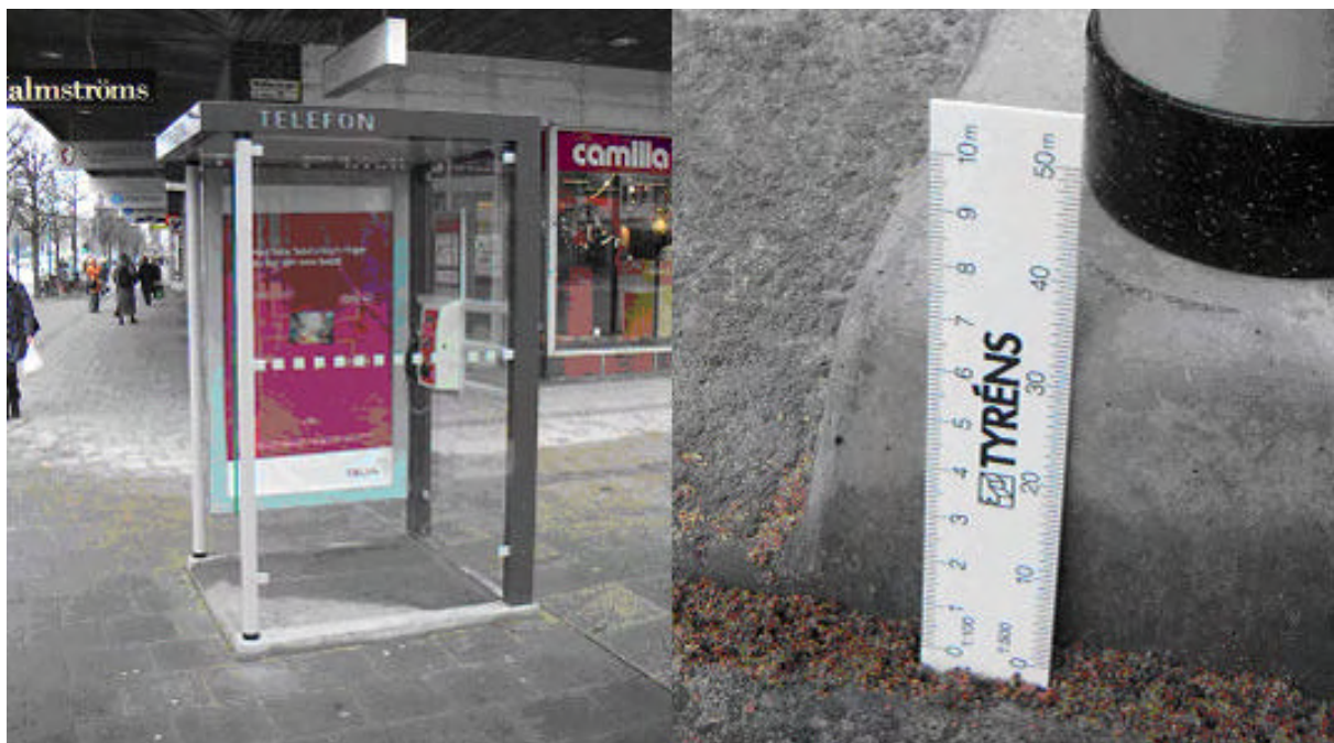
Figur 1.1 Telias nya telefonkiosk, med en fasad kant med 35 % lutning jämfört med 8 % som Boverkets föreskrifter (BFS 2003:19) har som maxlutning.
