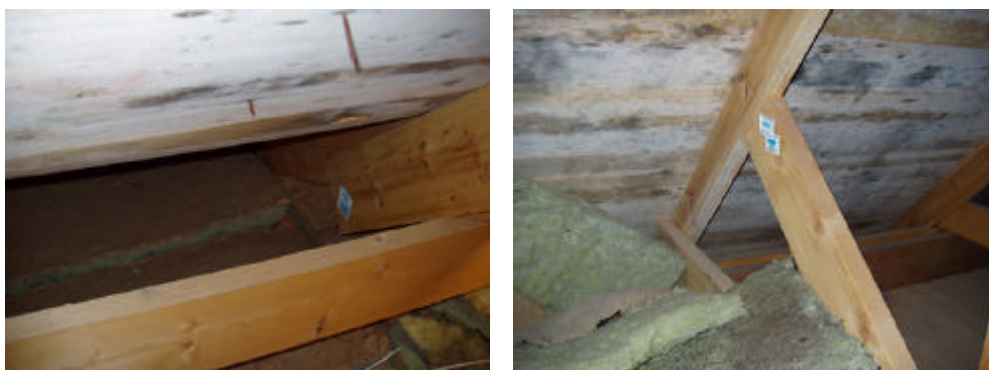
Figur 85 Indikatorer BI och HU placerade i par invid mögelskada. Indikator par nr 8 och 9 som alla visar fullt utslag efter två veckor.
