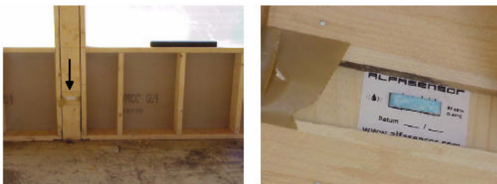
Figur 51 Placering av indikator för avläsning av utslag innan väggens insida färdigställs.
