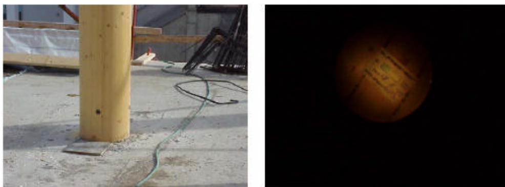
Figur 39 Avläsning av indikator inne i Conwoodstolpe genom inspektionshål.
