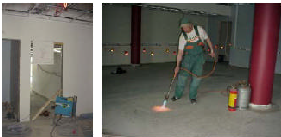
Figur 49 Upprättad skogräns i samband med bränning av plattan för att avlägsna organiskt material.
