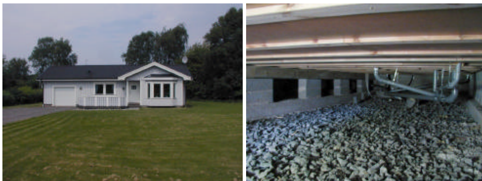
Figur 67 Hus B i Onsala samt en bild från dess kryprumsgrund.
