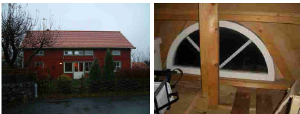
Figur 87 Hus B i Hovås samt en bild på vindsfönstret.
