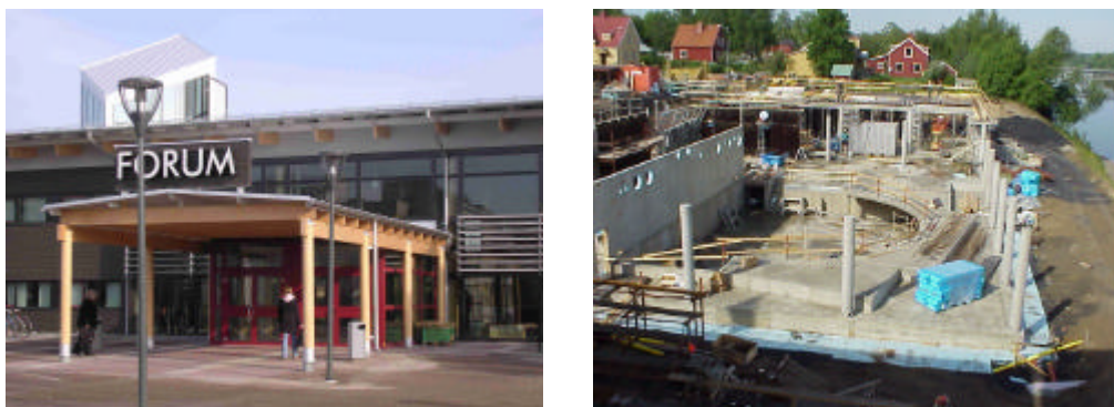
Figur 36 Färdigställd Huvudentré samt ”romerska arenan” under byggnation. Hörsal och biblioteksbyggnad på Campusområdet vid Skellefteälven.
