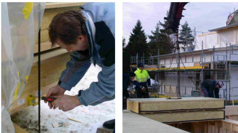
Figur 62 Demontering av mätinstrument samt montering av bjälklagselement
