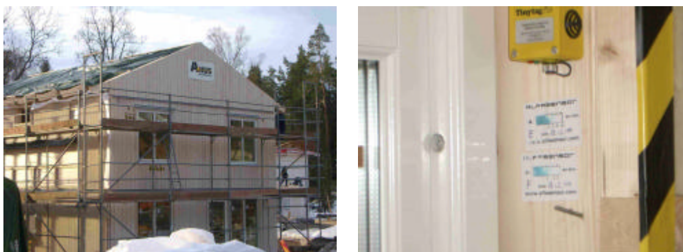
Figur 59 Väggelement monterat på plats i huskroppen samt Indikatorer och logger monterad i fönstervinkeln.
