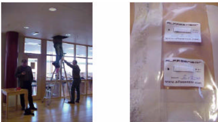
Figur 44 Avläsning av indikatorer i samband med besiktning efter att byggnaden brukats en tid.
