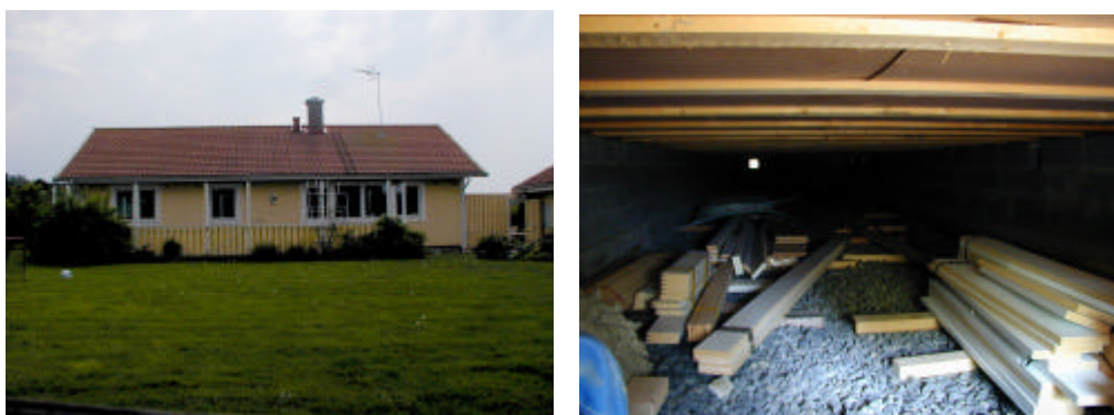
Figur 64 Hus A i Onsala samt en bild från dess kryprumsgrund.
