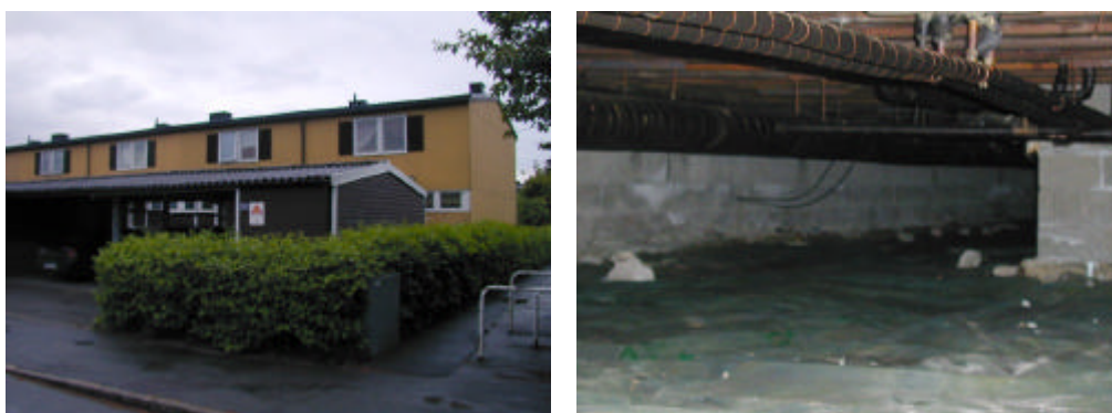
Figur 71 Hus 3 på Hisingen samt en bild från dess kryprumsgrund.
