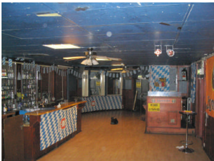
Bild 1. Scenen på Henriksbergs takterrass före ombyggnaden. Scenen är mycket liten och publiken hamnar mycket nära scenutrustningen och PA-högtalarna. Endast tunna textilier på scenväggarna och övermålade absorbenter i taket.
