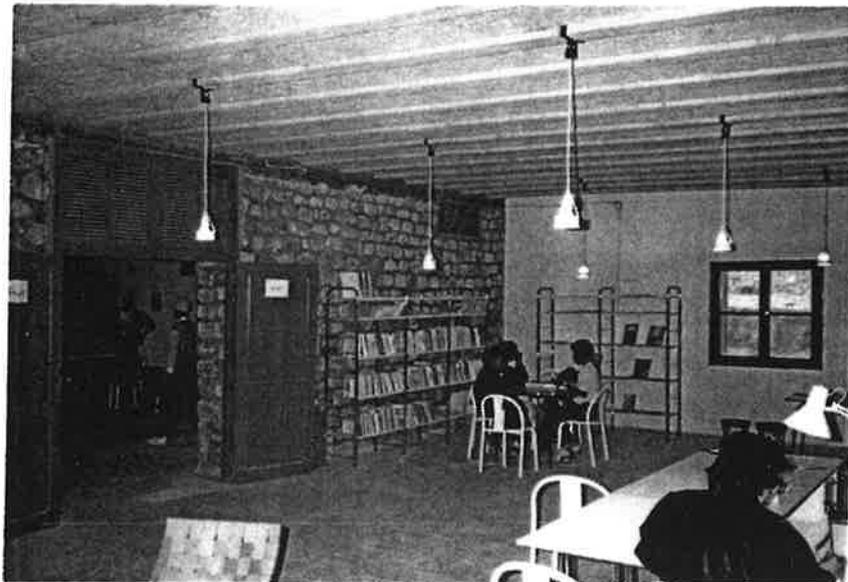
*Fig. 4.3.2. La maison de jeunes à Tameghza – intérieur. Panneaux en laine de bois dans la toiture et des murs en pierre pour le stockage thermique.*
