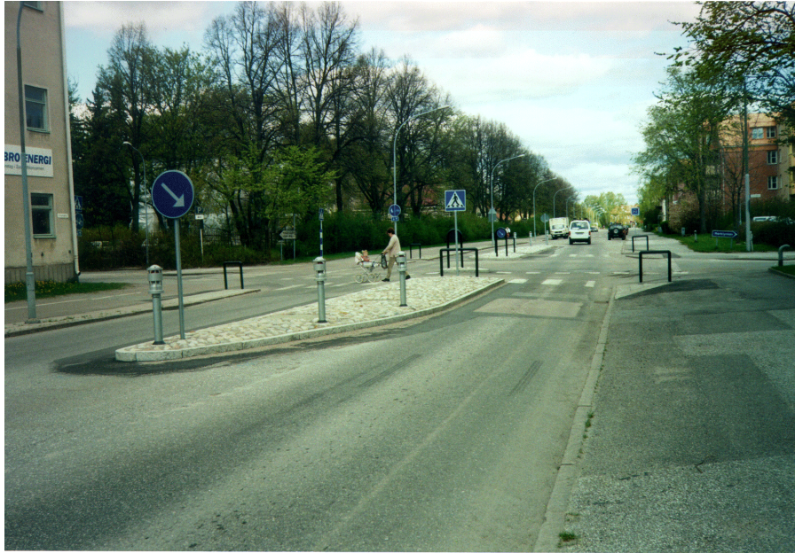
Figur 6.2 Korsningen Älvtomtagatan/Karlsbgatan i Örebro med väggkuddar, avsmalning av körbanan, långa och breda mittrefuger, handräcke och belysningspålar.
