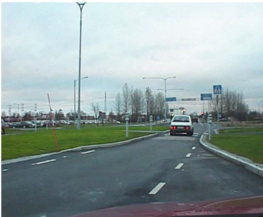
Figur 6.5 Planskiss på en försöksplats (F3 i figur 6.3) före och efter ombyggnaden samt ett foto på försöksplatsen efter ombyggnaden.
