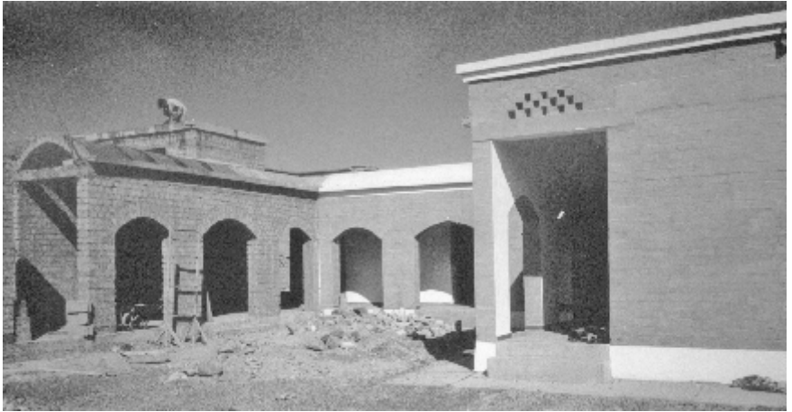
Fig. 5.14 Unité provinciale de LPEE à Ouarzazate: A droite, les bureaux et à gauche, le nouveau laboratoire (en cours de construction)
