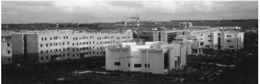
Fig. 1.1 Construction de 20.000 logements à Sala al Jadida à l'extérieur de Rabat-Salé
