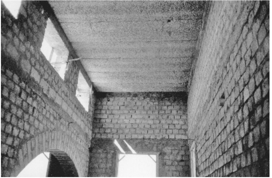
Fig. 5.17 Les panneaux de laine de bois autoporteurs placés sur les murs en blocs de terre comprimée constituent une des plus importantes modifications apportées au bâtiment. La face inférieure des panneaux n'est pas revêtue pour obtenir une bonne acoustique dans le local
