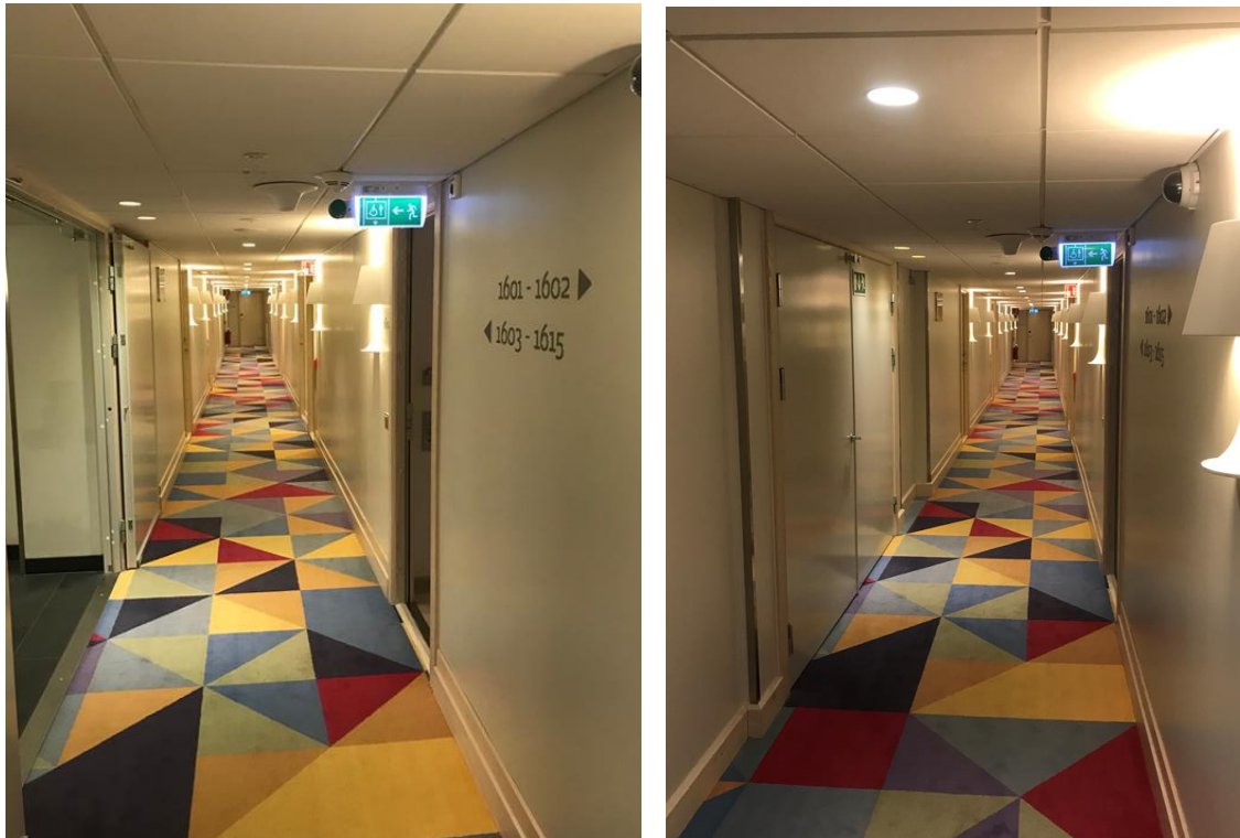
Figur 6. Hotellkorridoren med dörrarna till hisshallen uppställda (t.v.). Hotellkorridoren med dörrarna till hisshallen stängda. Den efterlysandes skylten på hisshallsdörren sitter högst upp på det passiva dörrbladet (t.h.).
