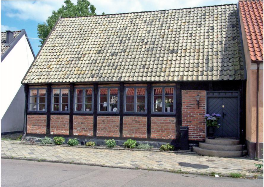
Fig. 10. Korsvirkeshuset på Stora Norregatan i Landskrona, uppfört år 1628. Huset är inte byggnadsminnesförklarat. Foto: Joakim Thomasson, 2008.
