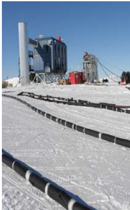
Över: Flygbild från Amundsen-Scott-basen vid Sydpolen där IceCube finns. Under: Slangen med varmvatten slingrar sig fram till borrhjulet intill IceCube-byggnaden.
