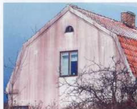
Bild 1: Fasader med kraftig påväxt av olika organismer.
