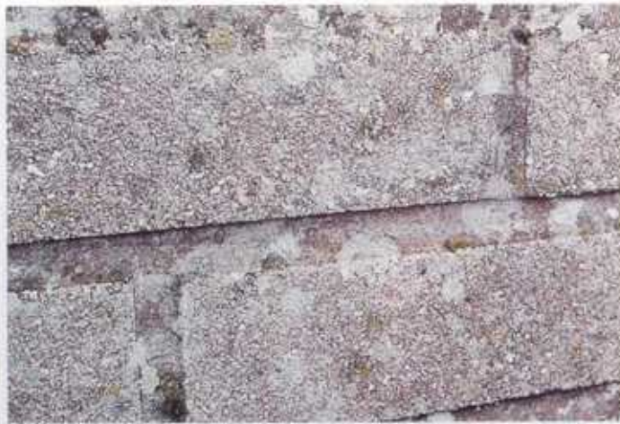
Bild 8: Olika lavar på fasader.
