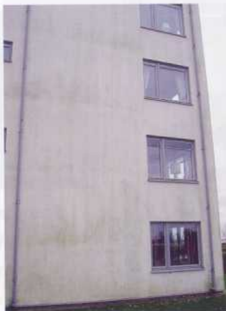
Bild 5: Fasad med påväxt av alg.
