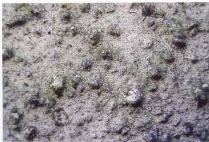
Bild 8: Olika lavar på fasader.
