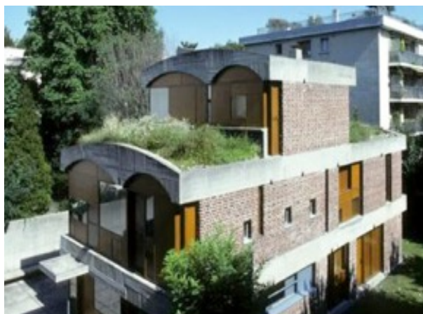
Figure 3.7: Green roof of Le Corbusier: Maison Jaoul (Hamatany, 2013)
