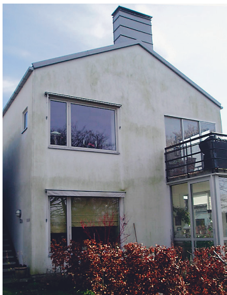
Bild 1: Fasader med påväxt av alger...
