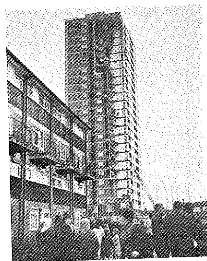
Fig 29. Fortskridande ras, orsakat av en gasexplosion i en hörnlägenhet på 18:e våningen, Ronan Point, Newham, London, den 16 maj 1968
