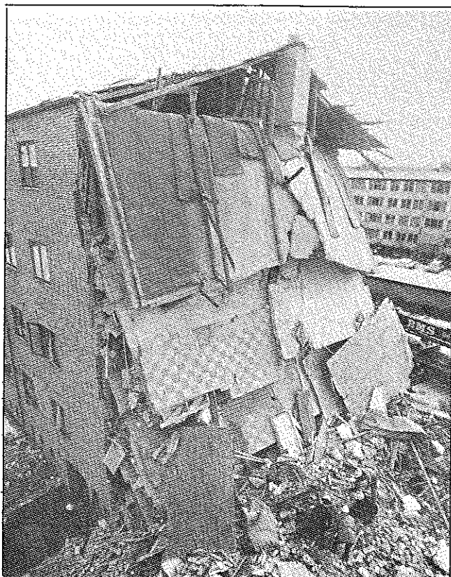
Fig 30. Fortskridande ras, orsakat av en gasexplosion i källaren i ett 4 våningars bostadshus i en av Københavns förorter, Skovlunde, den 2 december 1973
