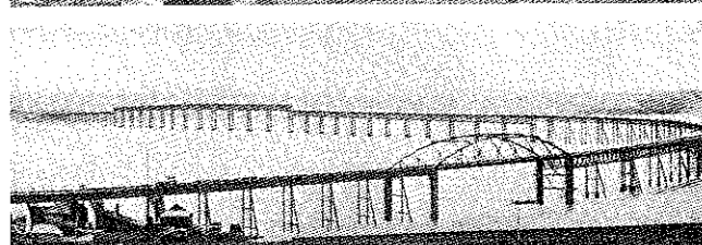
Fig 14. Fackverksbro i 88 spann över Firth of Tay vid Dundee i Skottland. Bron kollapsade den 29 december 1879, varvid 200 människor omkom
