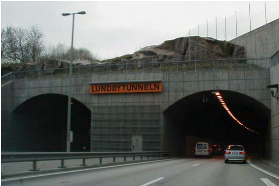
Figur 2.4 Lundbytunneln på Hisingen i Göteborg, ett exempel på flerfilig dubbelrörstunnel.
