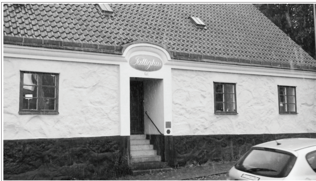
Figur 4.2. Fattighuset i Sölvesborg byggt 1821. Foto: T. Nieminen Kristofersson.
