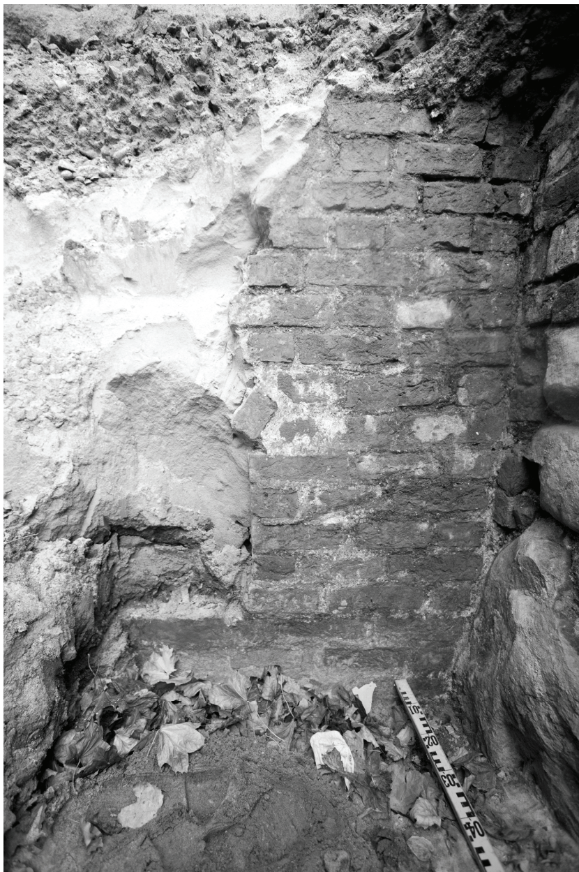
Figur 8. Den norra tvärmuren sedd mot norr. Längst nere till höger syns nischens östra del samt den nedersta stenen i avlastningsbågen. Foto: Mona Olsson.
