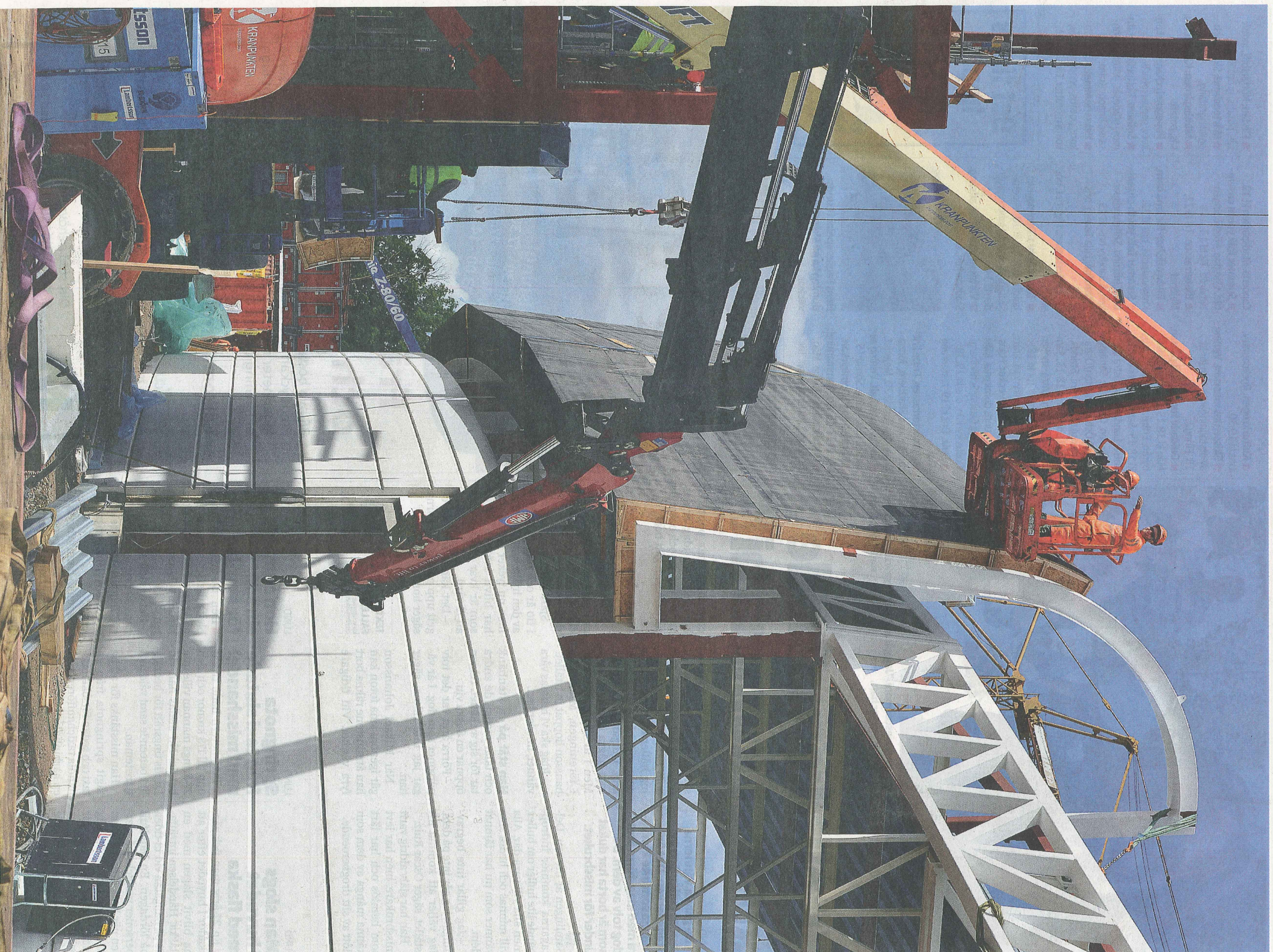
Ungefär 280 byggarbetaryr med att färdigställa Max IV. Här monteras ett byggelement för skalet kring stora ringen. Skalet innehåller bland annat trä och papp.
