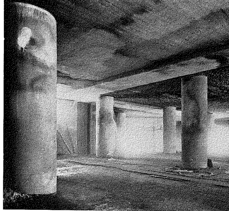
Fig 12. Övre källaren. Tak och pelare återställda i ursprungligt skick.
