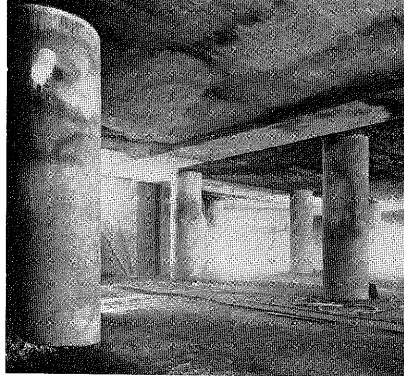
Fig 12. Övre källaren. Tak och pelare återställda i ursprungligt skick.
