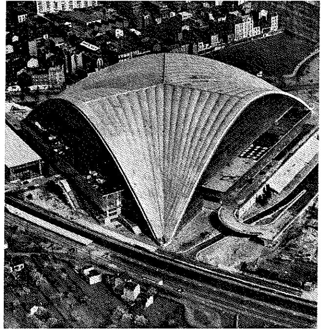
Fig 35. Trepunktsupplagt, armerat betongskal vid Rond Point de la Défense i Paris, bassidlängd 218 m
