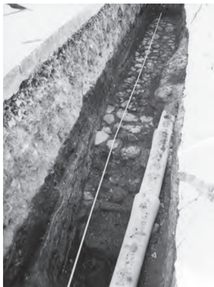
Figur 44. Stenläggningen i schakt C, från öster. Foto Sven Rosborn.
