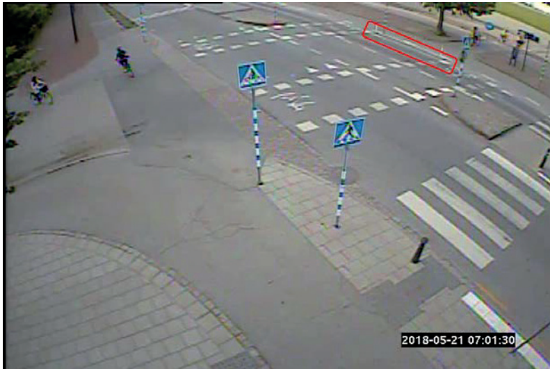
Figur 7 John Ericssons väg – Baltiska vägen Efter åtgärd, kantsten markerad i rött.
