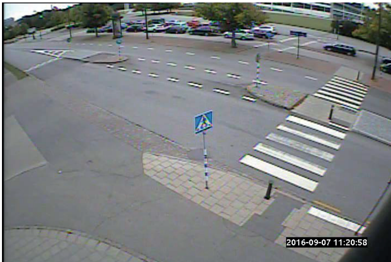
Figur 6 John Ericssons väg – Baltiska vägen Före åtgärd
