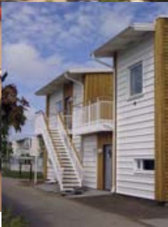
En av de nyuppförda byggnaderna på Dalhem, med ett av de äldre husen i bakgrunden.
