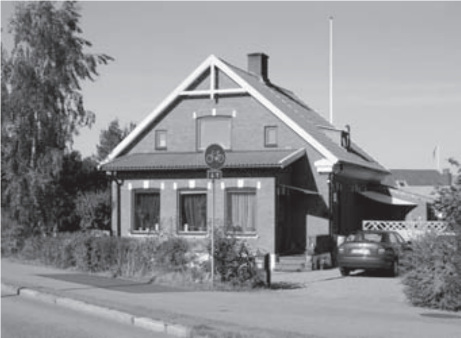
Boningshuset till Drottninghögsgården. Bilden är tagen från söder.
