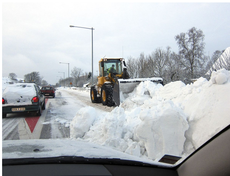
En farlig och krävande arbetsplats för både snöröjare och bilister. Köpingsvik, Öland, efter snöoväder julen 2010.
