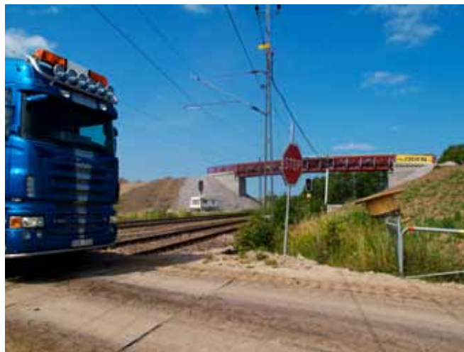
Under 2008 och 2009 genomfördes ett stort saneringsarbete av BT-kemiområdet. Av det efterbehandlade området skapades en tätortsnära naturpark.
