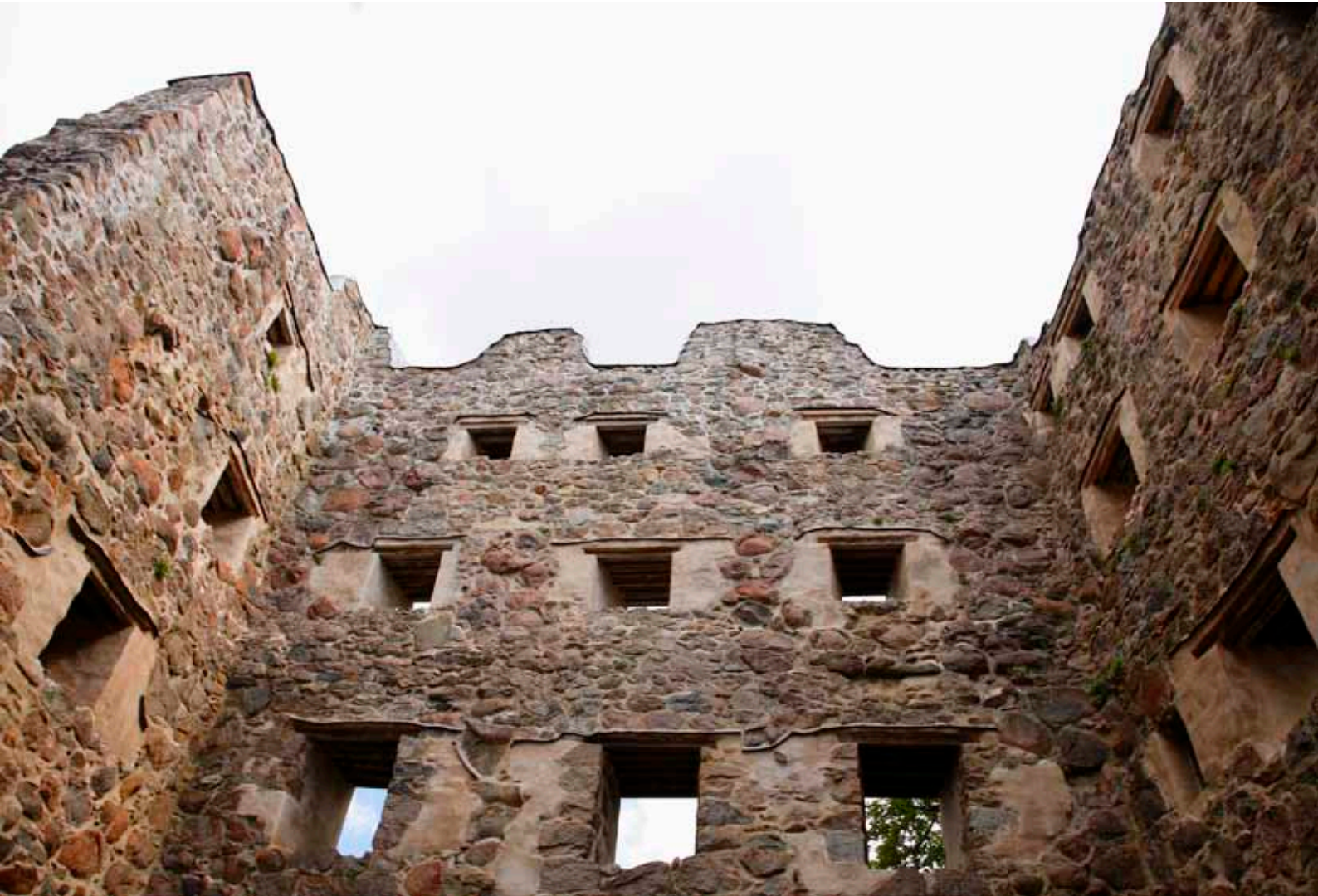
Stenhusets östra gavel där de stora fönstren gav ljus och en vacker utsikt över sjön.
