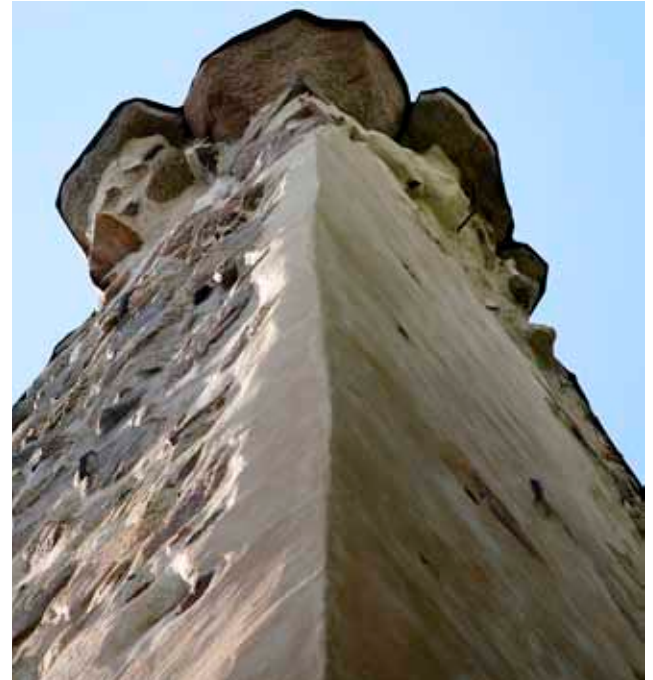
De utskjutande stenarna i ruinens hörn är de kvarvarande resterna efter hängtornen.
