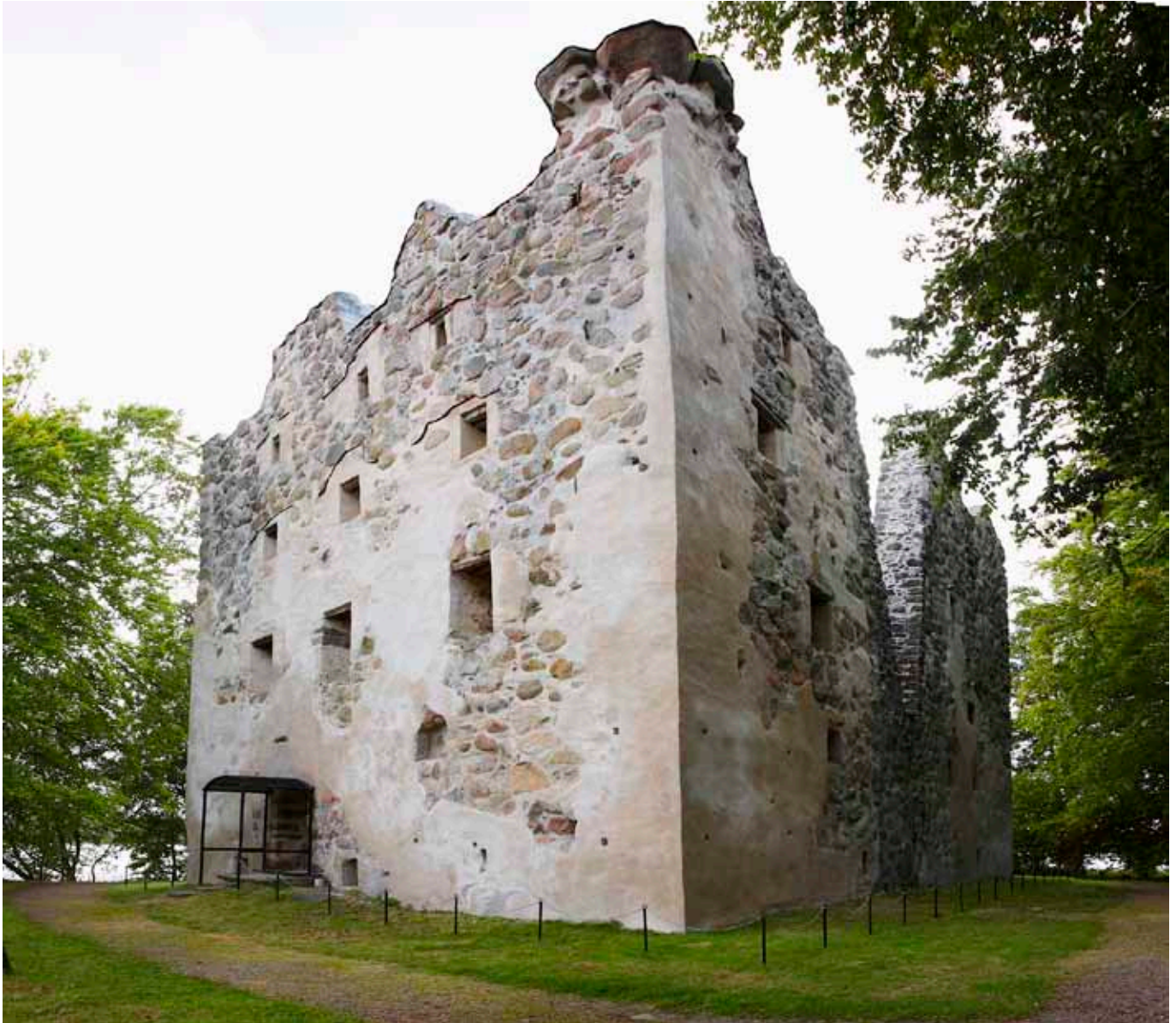
"Gamla stenhuset i Bergkvara stod ännu till sina murar för ett spektakel och en antikvit. Det var byggt fyrkantigt som ett flaskfoder, 40 alnar högt, 34 långt, 24 brett. Det var uppfört av kullerstenar." Carl von Linné 1749.
