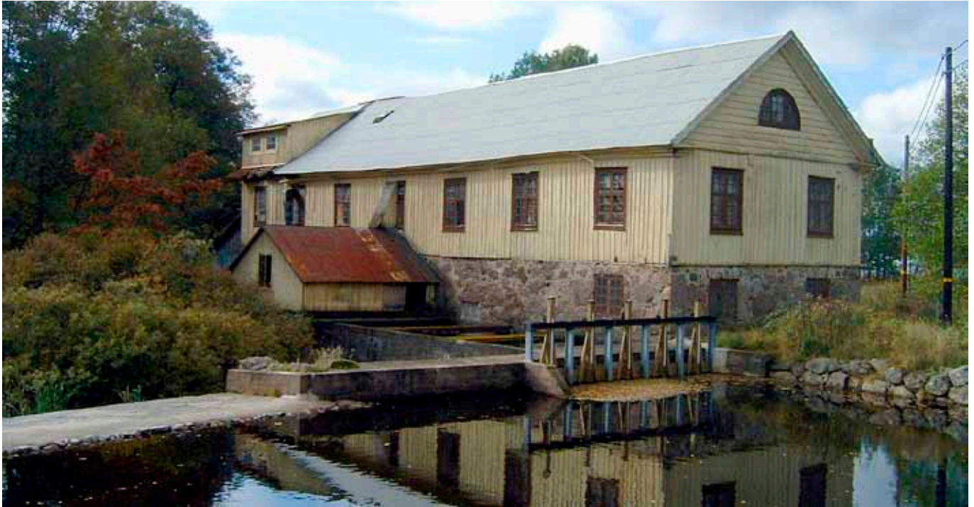
Örsleds kvarn före restaureringen 2008.
