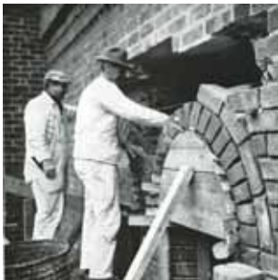
Figur 18. Arbetet med att åter- skapa klostrets medeltida fön- steröppningar på 1960-talet.
