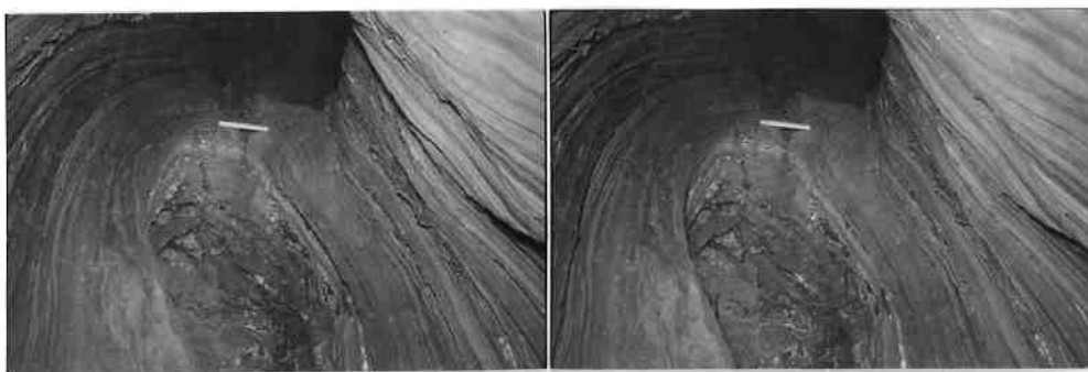
Fig.110. NO-gången vid punkt 65,4. Genombrutet glimmerskifferlager. Mot sydost. 27/8 1954.
