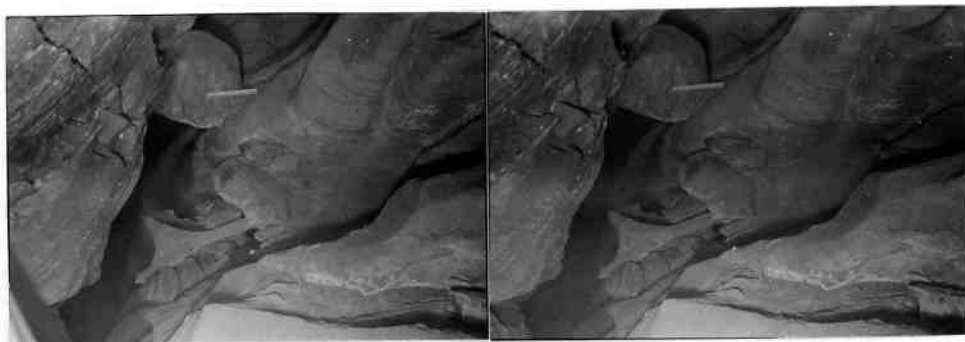
Fig. 91 . Från DE-gången. Genom hål i andra våningens golv skymtar man bäcken. Ett urbergsblock sitter fastkilat mellan våningarna. Kameran riktad nästan lodrätt. 22/8 1954.
