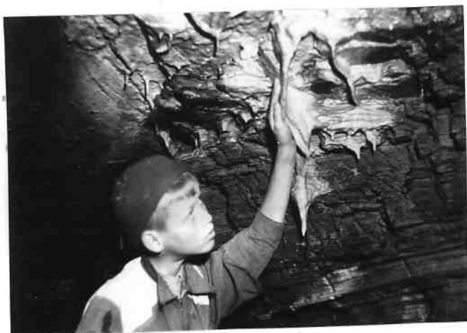
Fig. 116 . Kraftig droppstensbildning på gångens norra vägg vid Q. 19/8 1953.
