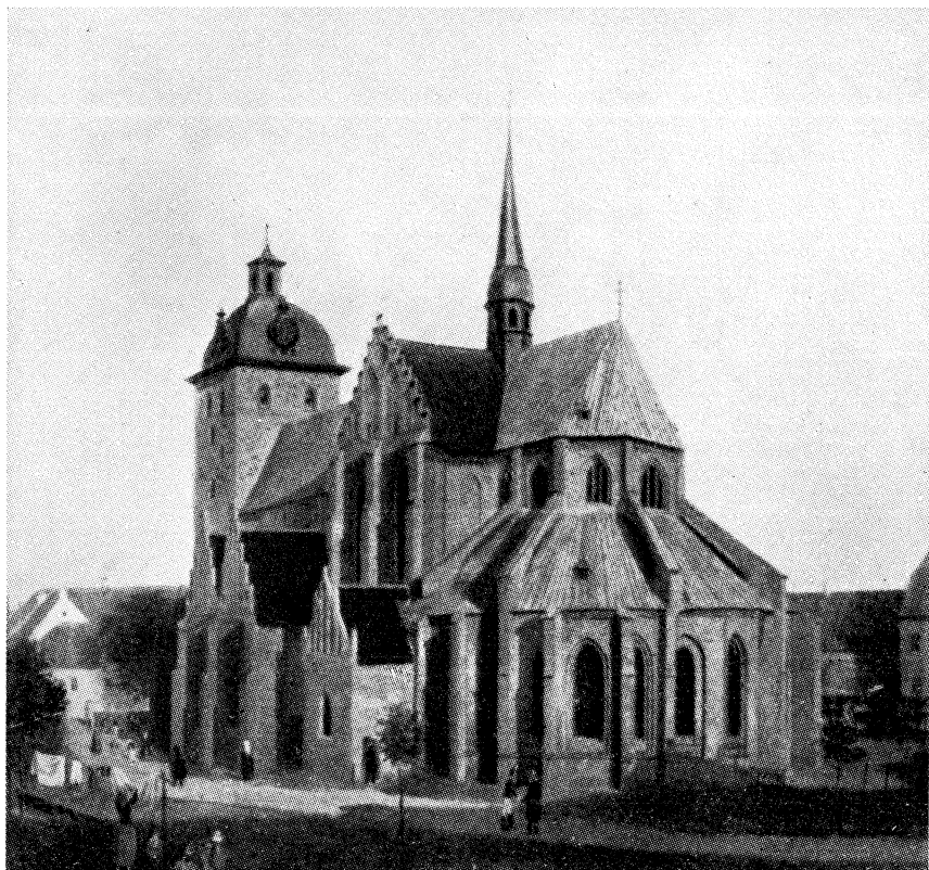
St. Petri kyrka i Malmö före den genomgripande ombyggnaden på 1800-talet. Två av sidokapellen äro tydligt synliga. Oljemålning från 1843
