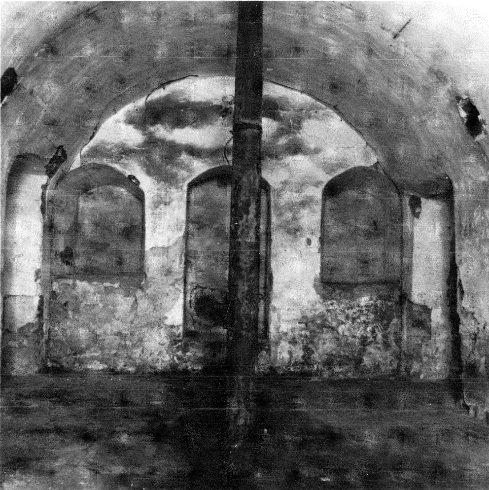
Fig. 4:46. Östra väggen i rum B 103 i bottenvåningen av östra längan med två ursprungliga nu igensatta fönsteröppningar på var sin sida om privetöppning eller eldstad. (Foto: S. Johansson 1986.)
