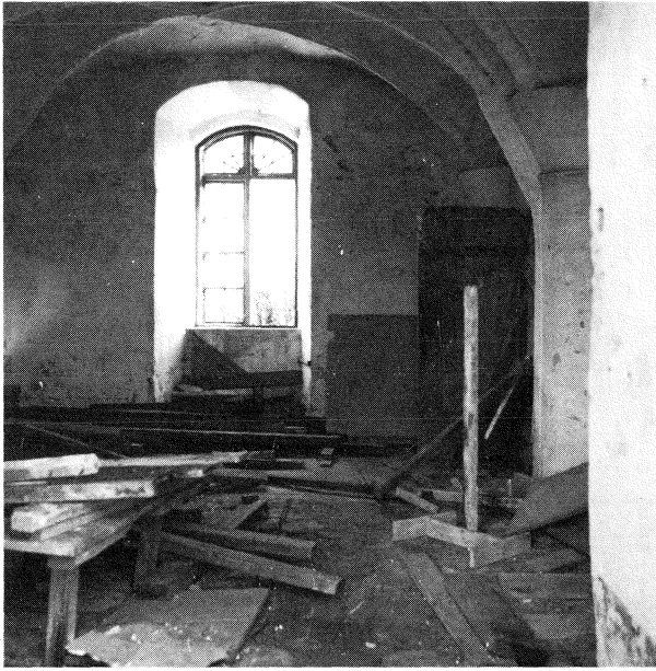
Fig. 4:47. Slottskapellet i bottenvåningen av östra längan (Rum B 101). Från dörröppningen i väster. (Foto: S. Johansson 1980.)
