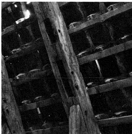
Fig. 5:10. Spærfag 12 med taphuller til hanebånd og kopbånd. (Foto: F. Beyer 1985.)
