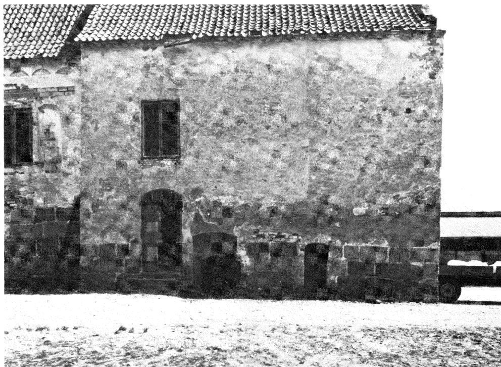
Fig. 4: 26. Västra sidan av södra längans återstående del med östra sidan av portgenomgången i bottenvåningen. (Foto: S. Johansson 1984.)
