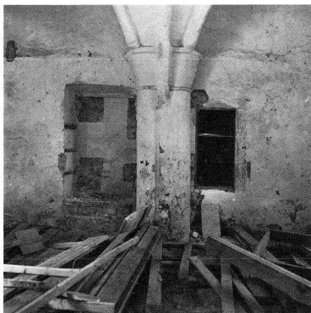
Fig. 4: 49. Slottskapellets norra vägg med dubbla nischer och kolonner. Nischerna kan ursprungligen ha fungerat som fönsteröppningar till dess att norra längan uppfördes omkring 1590. (Foto: S. Johansson 1982.)
