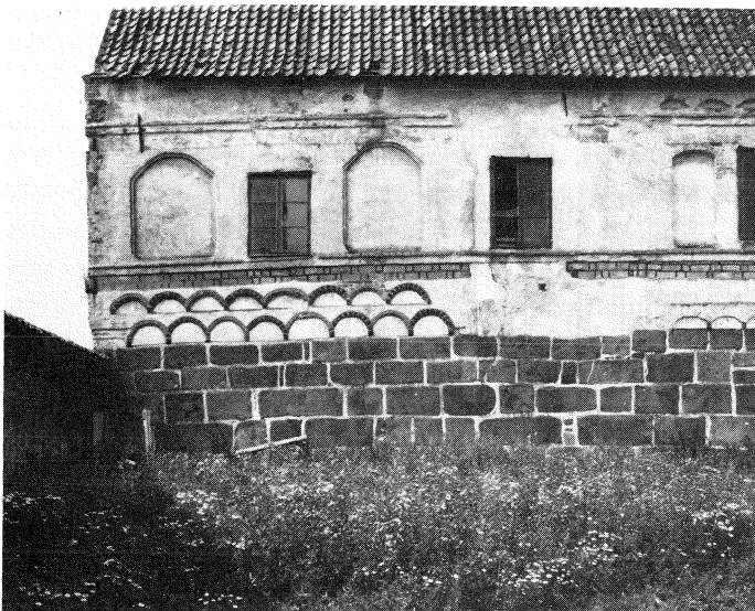
Fig. 4:22. Den återstående delen av södra längans östra gavel. (Foto: S. Johansson 1977.)
