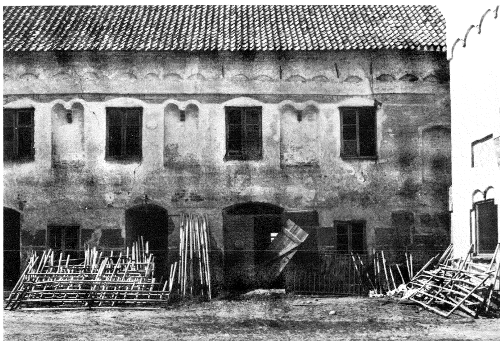
Fig. 4: 58. Västra längans borggårdsfasad, norra delen. (Foto: S. Johansson 1984.)
