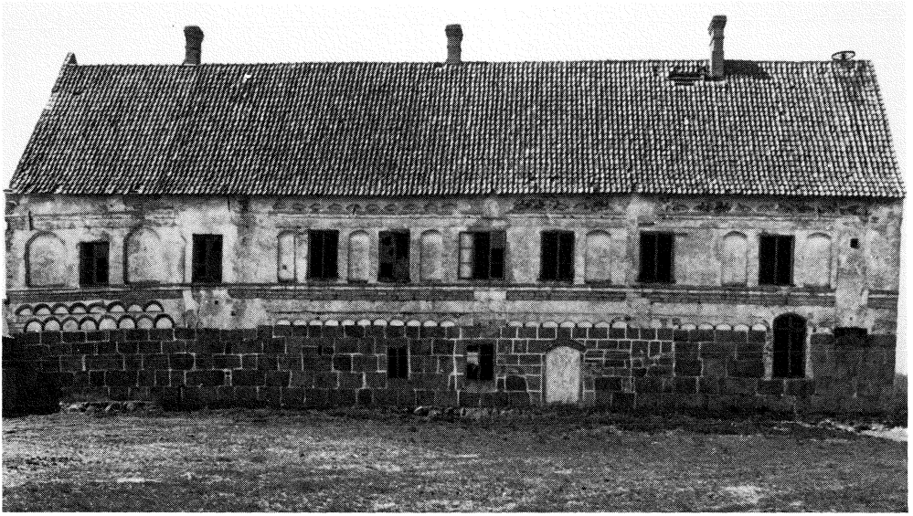
Fig. 4:6. Frontfoto från öster med den resterande delen av södra längan och östra längan som är bevarad i sin helhet. (Foto: S. Johansson 1984.)
