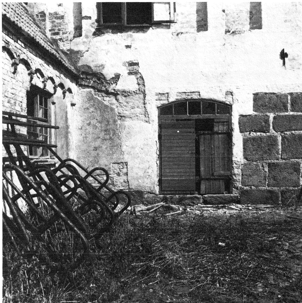
Fig. 4: 41. Kapellfönstrets södra fals utanför envåningsbyggnaden och den nuvarande dörröppningen. Här har det ursprungligen funnits en mindre dörröppning till kapellet. (Foto: S. Johansson 1982.)
