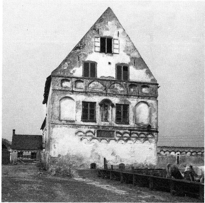
Fig. 4:21. Den återstående delen av södra längans sydfasad. (Foto: S. Johansson 1978.)
