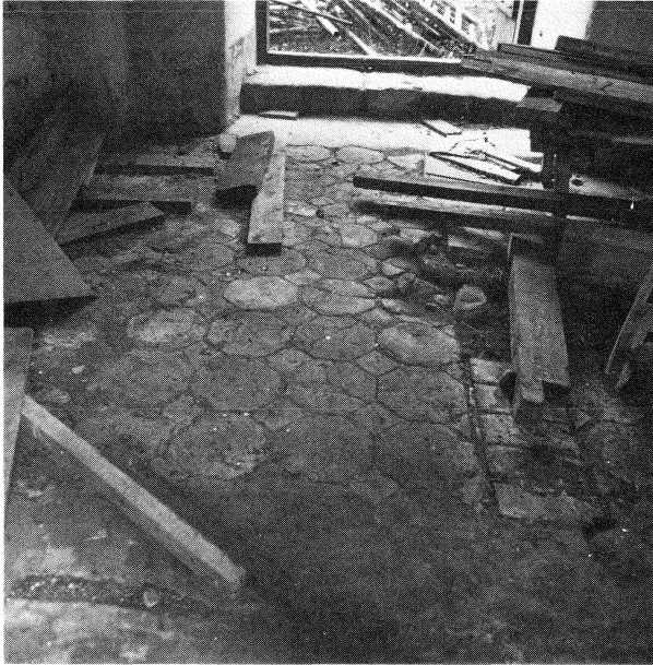
Fig. 4:50. Det ursprungliga tegelgolvet i slottskapellet. (Foto: S. Johansson 1980.)
