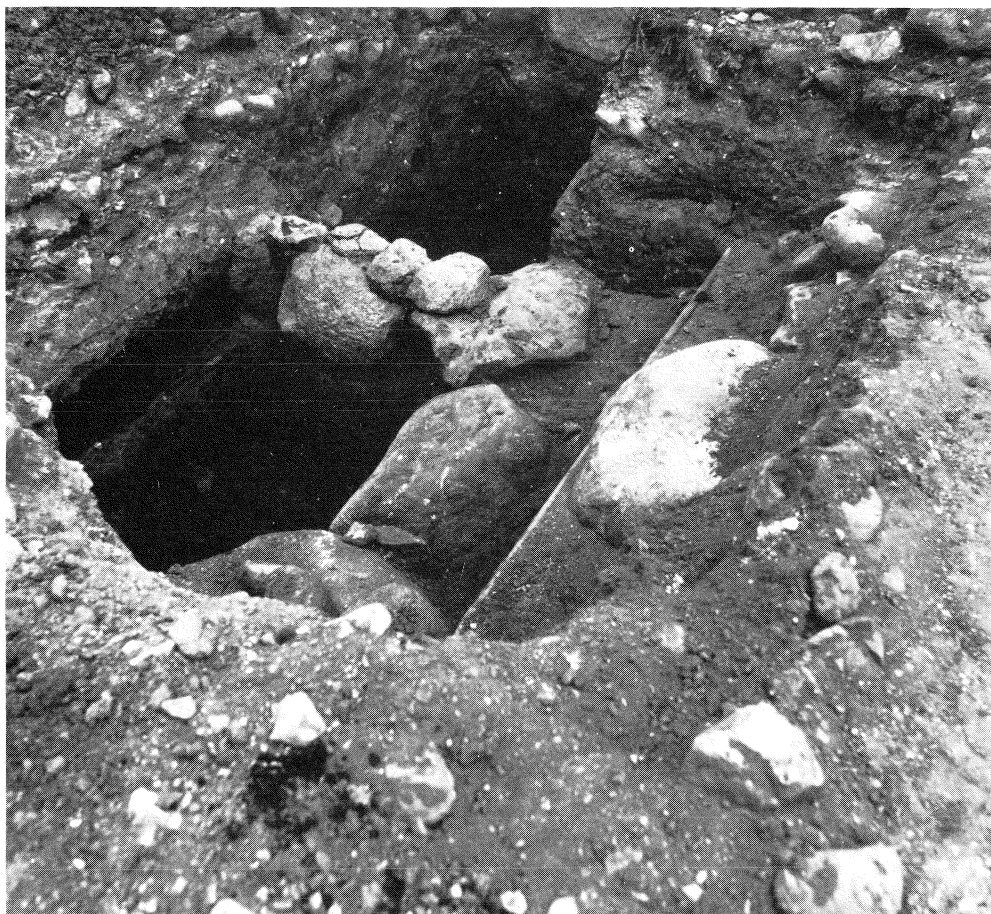
Fig. 2: 7. Schakt 1 från sydväst med en stenmurskonstruktion som tolkats som fundament till en korsvirkesbyggnad från övergången mellan 1300- och 1400-talen. (Foto: S. Johansson 1986.)
