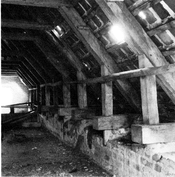
Fig. 5:2. Den østre langside af vestlængens omsatte tagværk. (Foto: F. Beyer 1985.)
