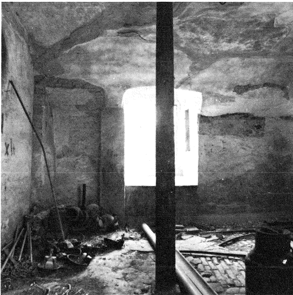
Fig. 4: 44. Östra väggen i rum B 104 i bottenvåningen av östra längan. Till vänster om fönstret finns ett ursprungligt nu igensatt fönster. Det nuvarande fönstret har från början fungerat som privet eller eldstad. (Foto: S. Johansson 1982.)
