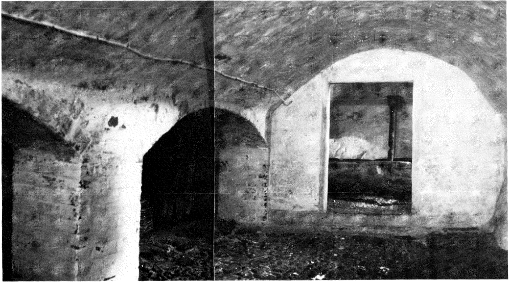
Fig. 6:5. Bratskov. Den sydøstre del af kælderetagen. De to parallelle, fladbuede tøndehvælv støttes af kvadratiske piller, forbundet med fladbuede stik. Foto HHE 1980.
