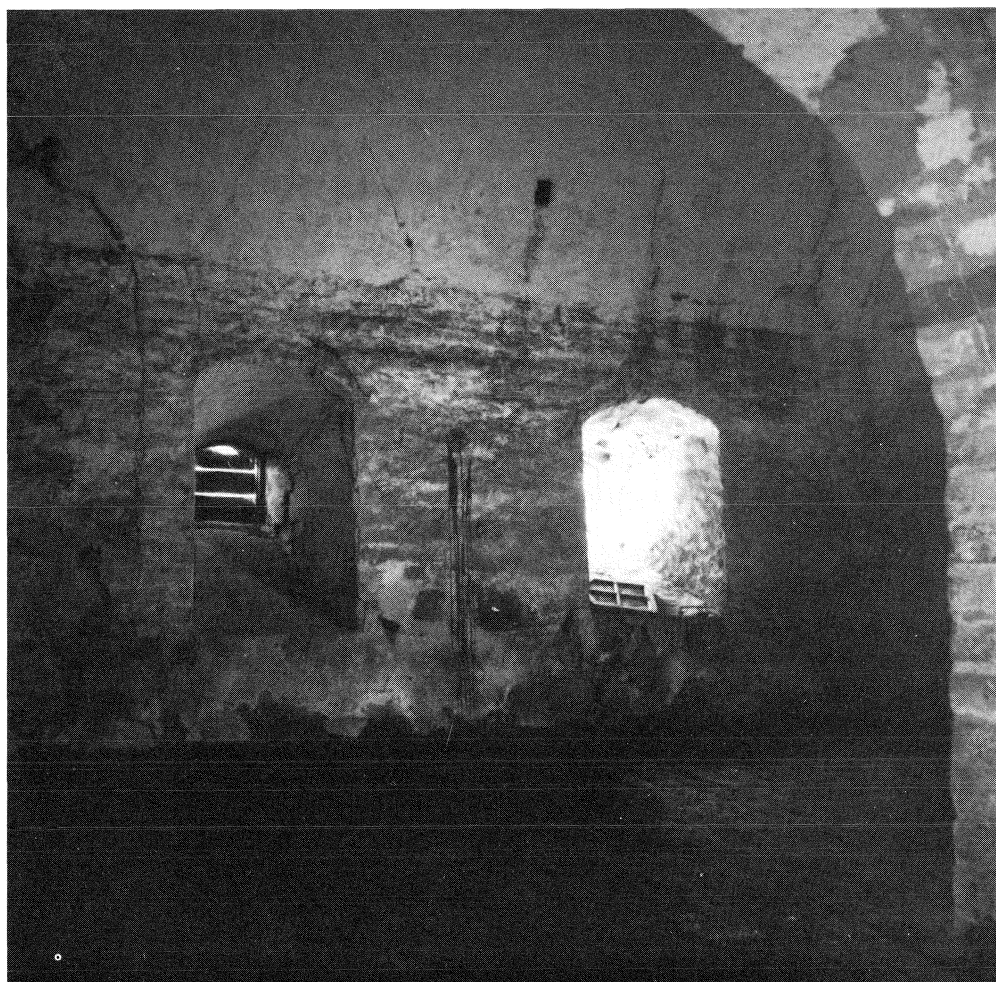
Fig. 4:34. Källaren i södra längan (Rum A 102) från nordväst med sydväggens ursprungliga ljusgluggar. (Foto: S. Johansson 1986.)
