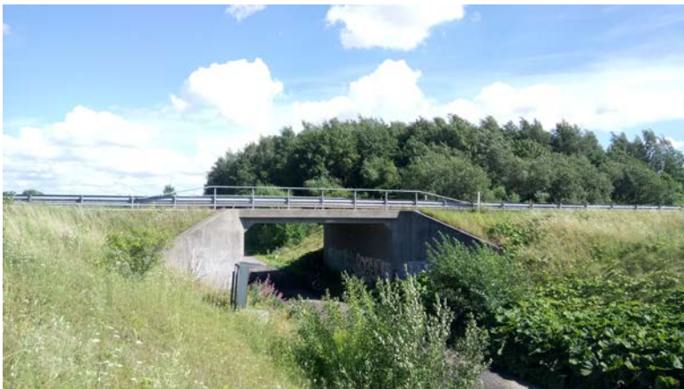
Figur 4.1. Bild på plattrambro som använts vid validering av användning av STRÅNG-data för temperatursimulering. Bild tagen 2017-07-31.
