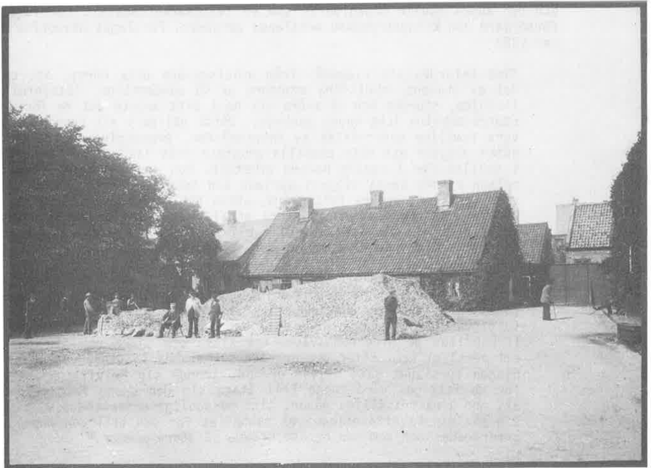
Foto nr 4. Utsikt över gårdsplanen. Mitt över densamma låg den makadam, som arbetsoviljiga och även gamla män stod och slog. Bakom makadamen syns det ena envåningshuset vid Själbodgatan, grinden och porten.
