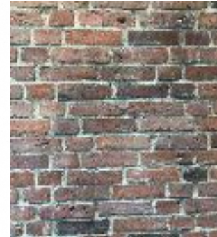
Munkförband (2 löpstenar, 1 koppsten)
