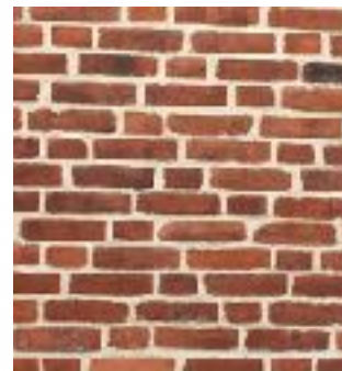
Blyxförband, vilket är ett munkförband med en annan förskjutning.
