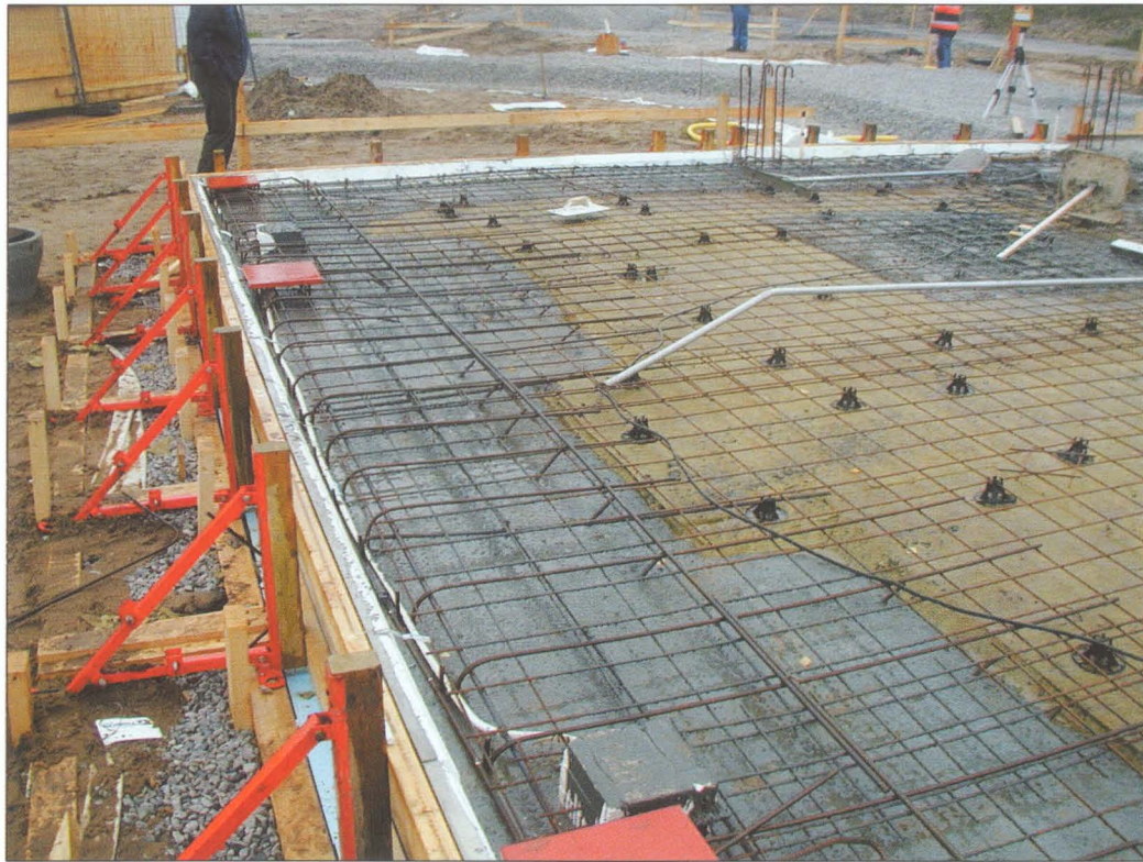
Gjutning av betongplatta till fältförsök av betongtorkning (N.Johansson)
