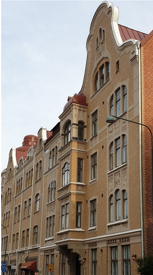
Bild 1.3. Burspråk och frontespiser med organisk form är vanliga inslag i jugendarkitektur. Denna byggnad har fasader av förbländertegel. Typiskt för förbländertegel är att det är hårt bränt och murades med enbart koppytor och smala fogar.
