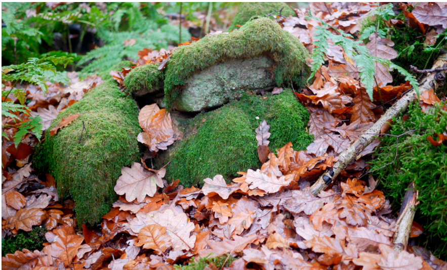
Figur 5. Detalj av muren i den norra delen av byggnaden. Foto Kristina Jennbert 2020.
