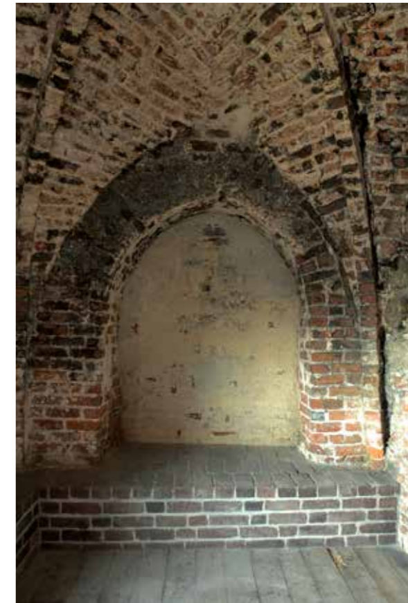
Foto från insidan av nischen mot trapptornet i den sekundära västra kammaren. Här inrättades en biläggareugn som eldades från trappgången och skapade en rökfri miljö i kammaren.
