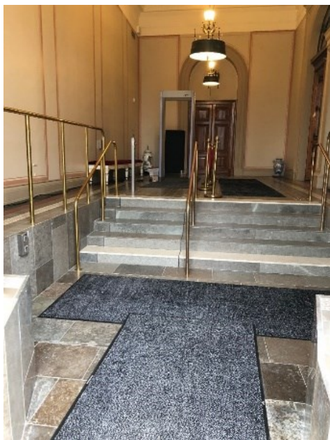
Figur 3. Ny huvudentré till Börshuset med flexibel och kombinerad lyftplatta/trappa.
